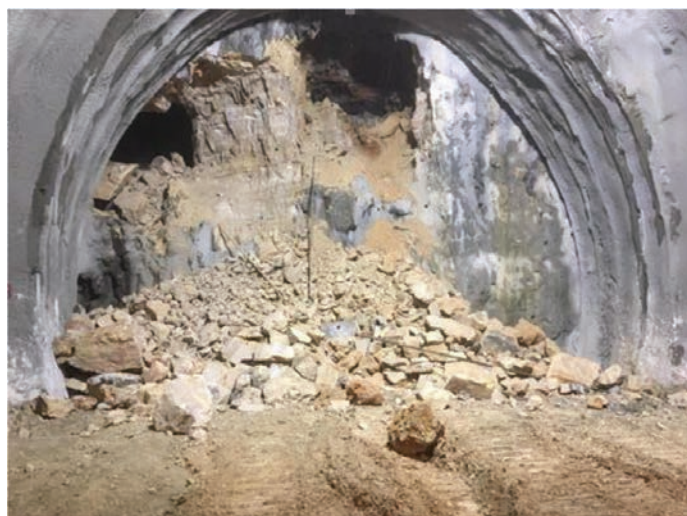
Figura 7. Intercettazione di cavità carsiche da parte dello scavo.
