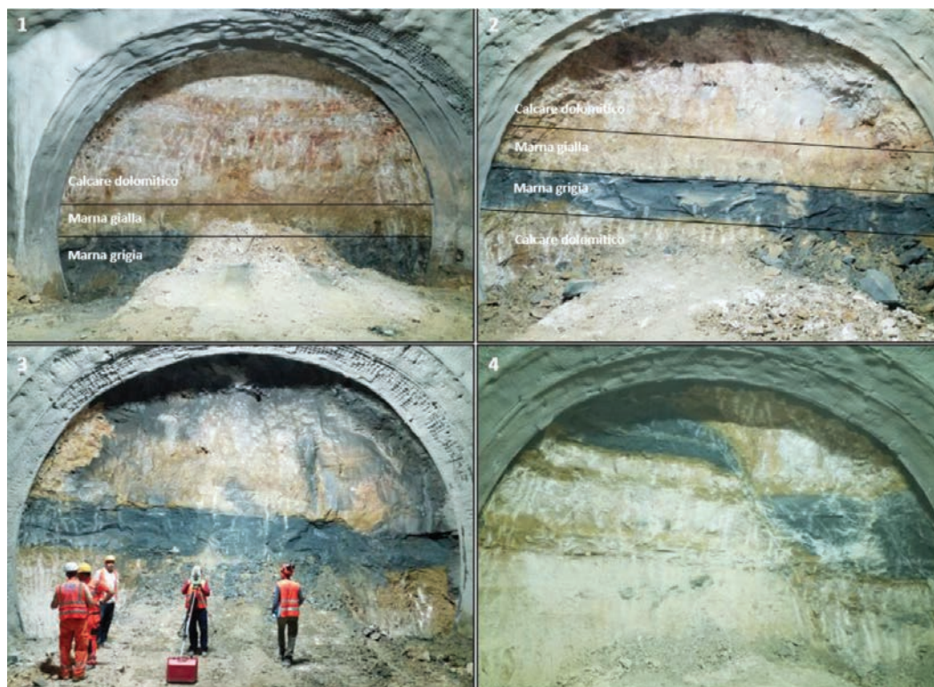
Figura 6. Rilievi del fronte di scavo durante l'attraversamento nella Motza.
