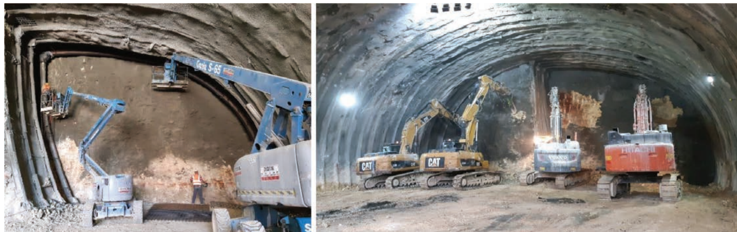
Figura 20. Sezione EX-3. (a) Scavo della prima porzione; (b) sezione completa.
