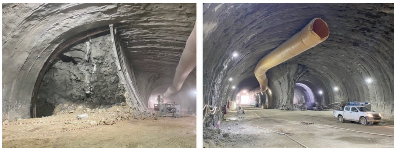
Figura 36. Immagini della biforcazione in fase di scavo.
