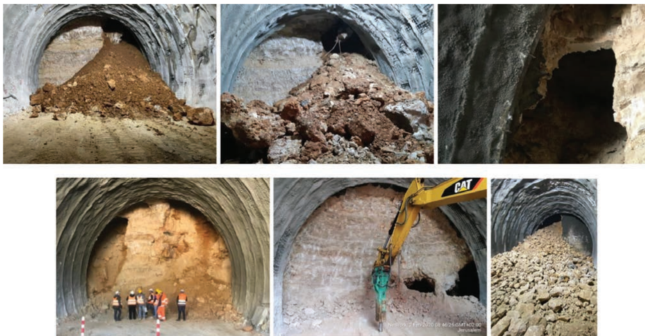
Figura 28. Esempi di fenomeni carsici riscontrati durante l'avanzamento degli scavi.
