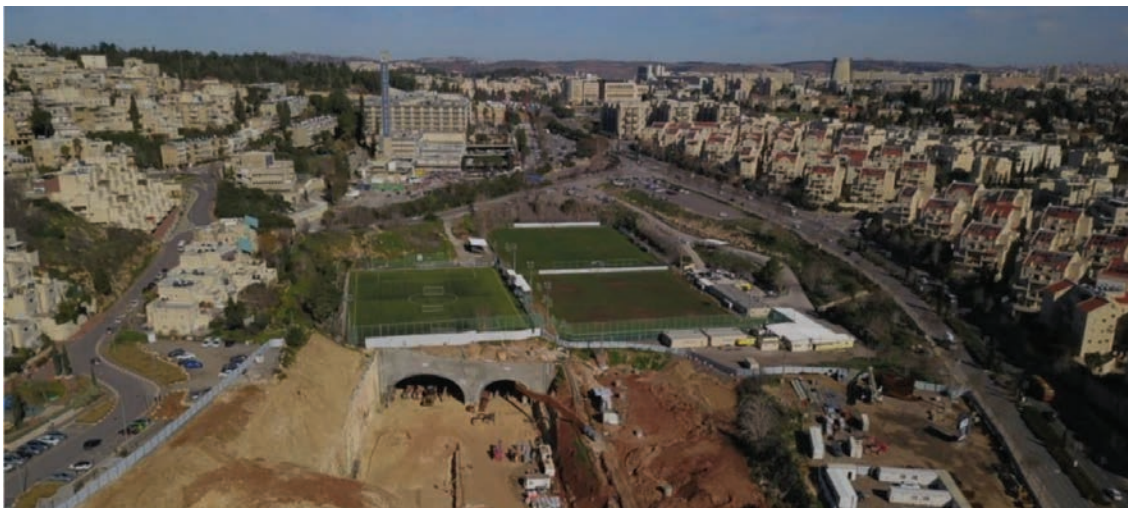
Figura 21. Vista da drone dell'imbocco lato Bayth durante la costruzione.
